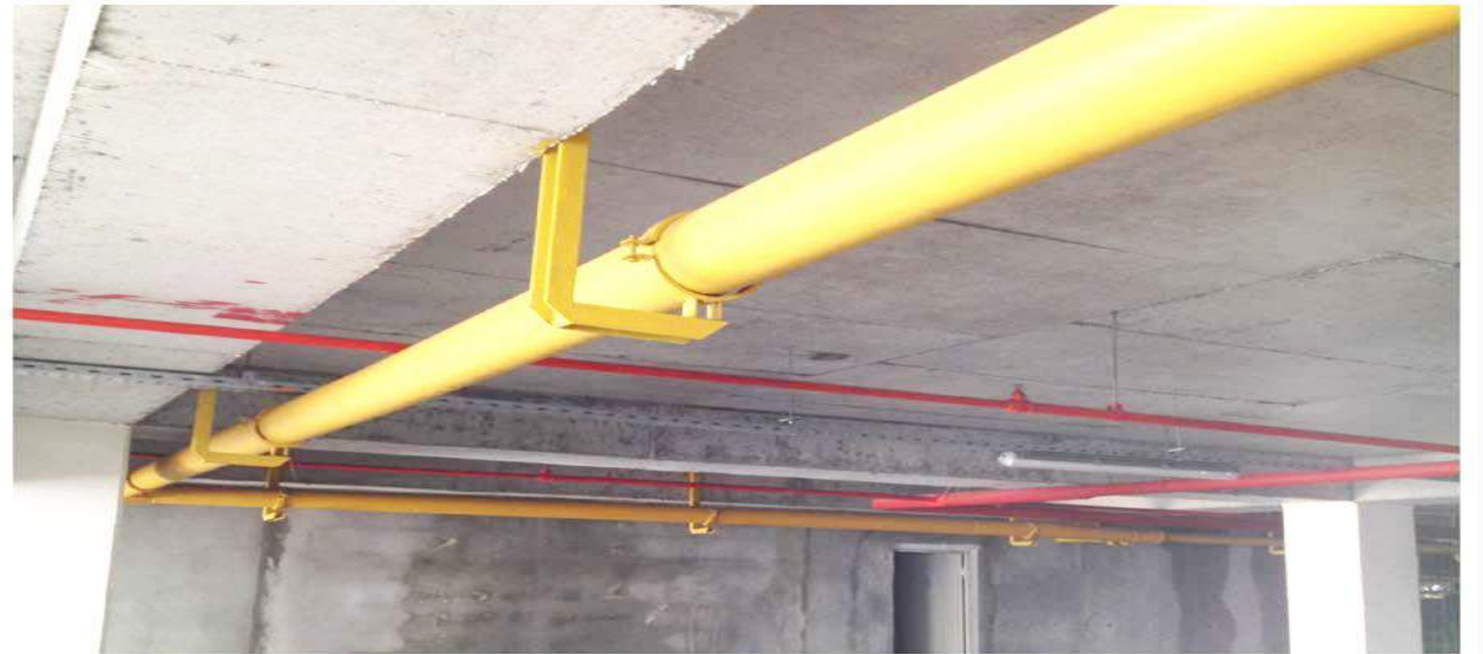
KRİSTALŞEHİR – BEYLİKDÜZÜ 1.KISIM DOĞALGAZ KOLONTESİSATI
