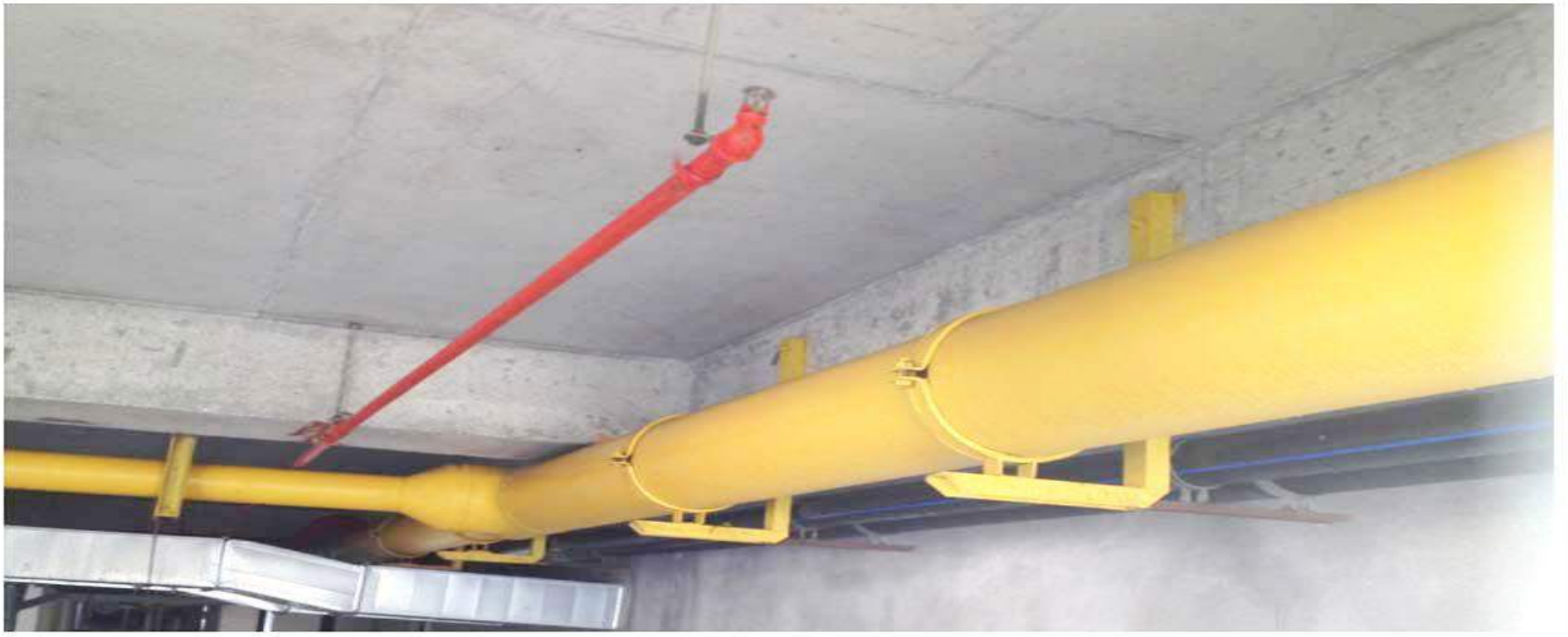
KRİSTALŞEHİR – BEYLİKDÜZÜ 1.KISIM DOĞALGAZ KOLONTESİSATI
